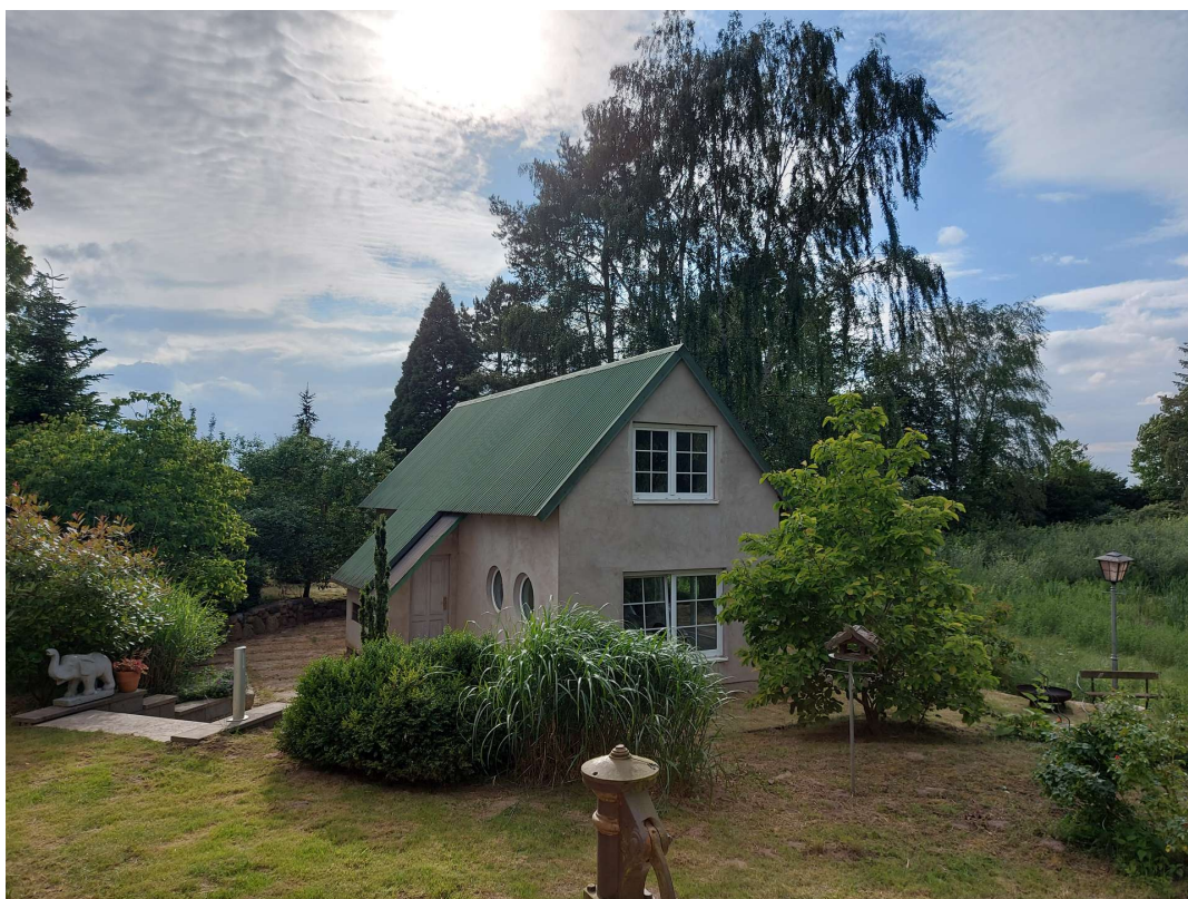
Zweites Wohnhaus (Gästehaus)
